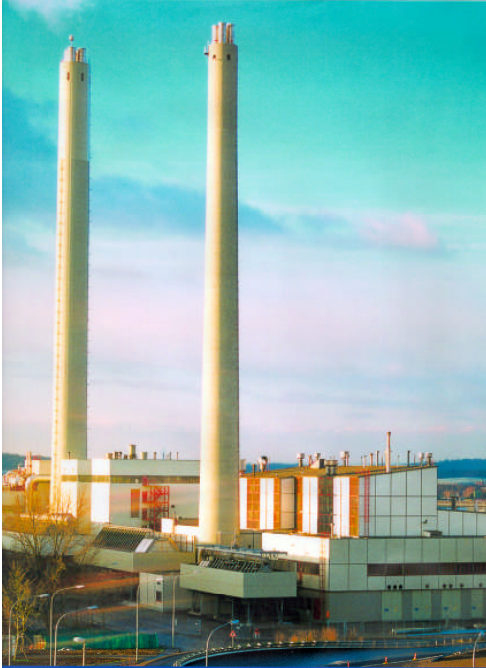
Abb. 3: Heizkraftwerk der DaimlerChrysler AG in Sindelfingen
