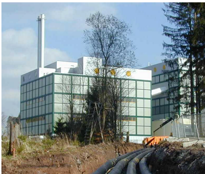
Abb. 4: Fernwärmeanbindung an das Restmüllheizkraftwerk Böblingen
