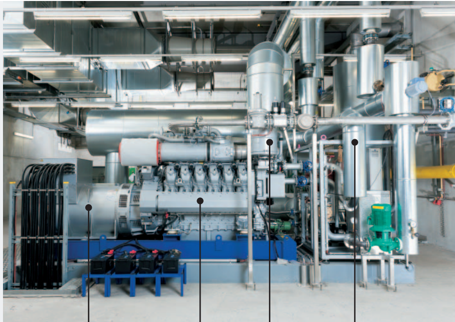
Stromgenerator Gasmotor Abgaswärme Motorwärme
