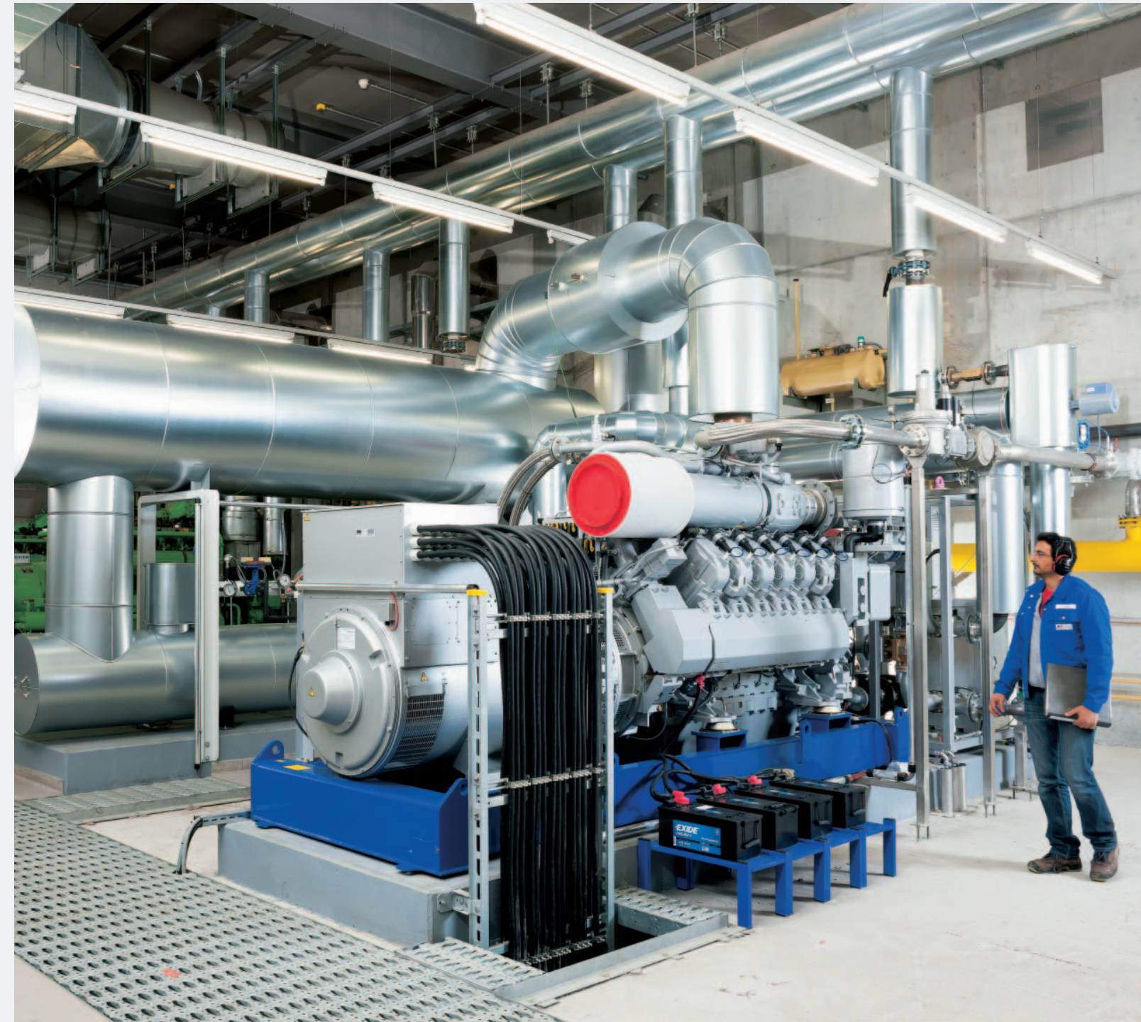
Dieser Gasmotor des Heizkraftwerks Grünäcker wird ausschließlich mit Bio-Erdgas betrieben
