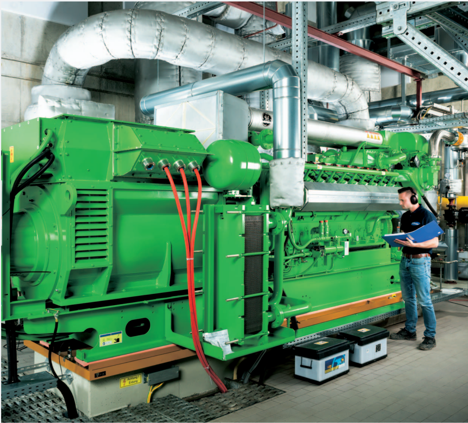
Gasmotor und Stromgenerator im Heizkraftwerk Grünäcker
