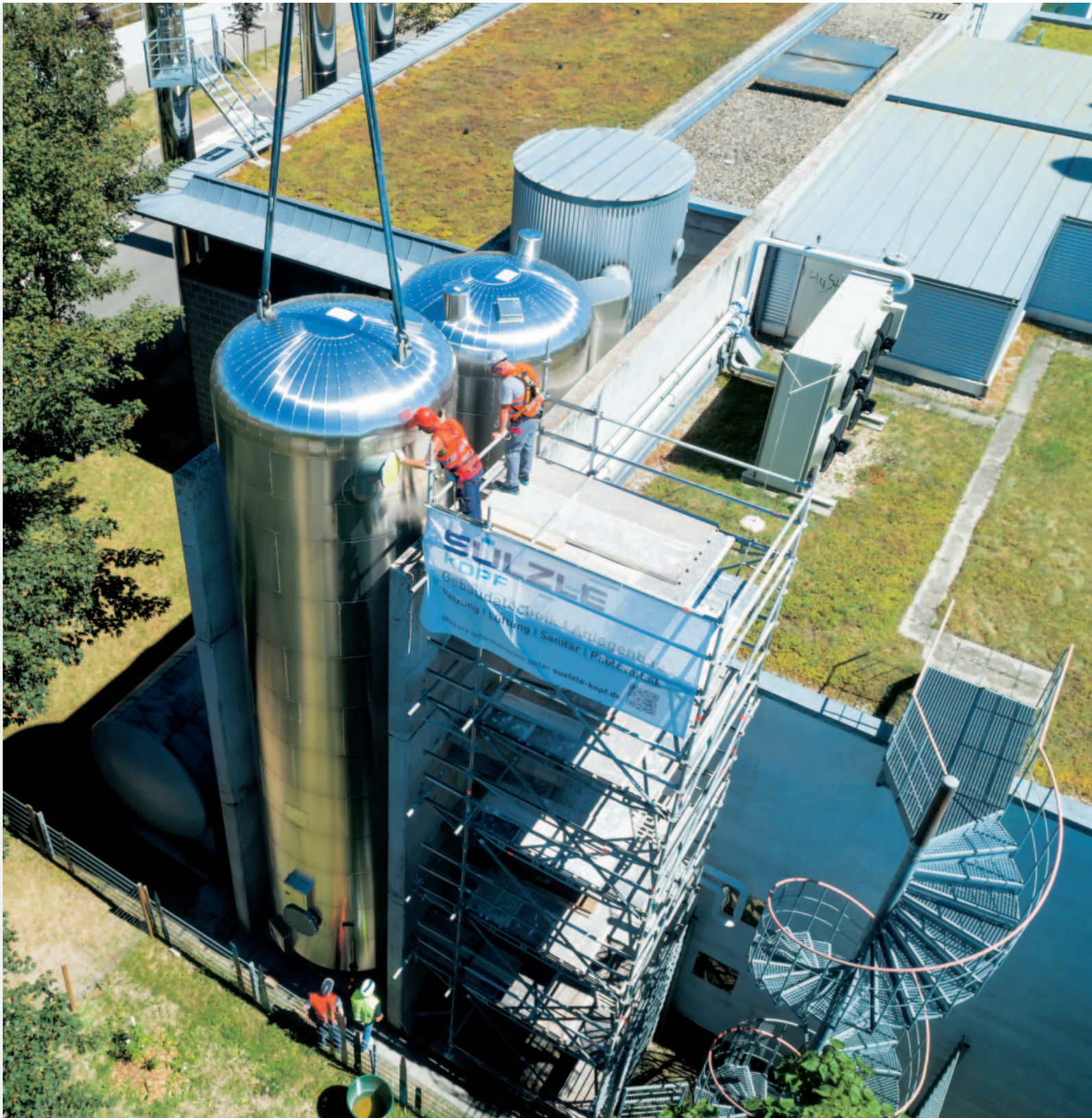
Zwei zusätzliche Wärmespeicher werden installiert
