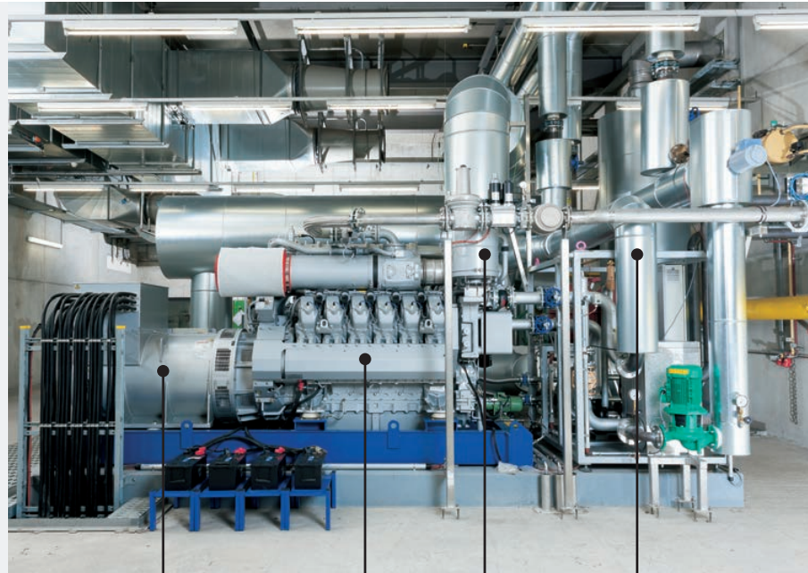
Stromgenerator | Gasmotor | Abgaswärme | Motorwärme
