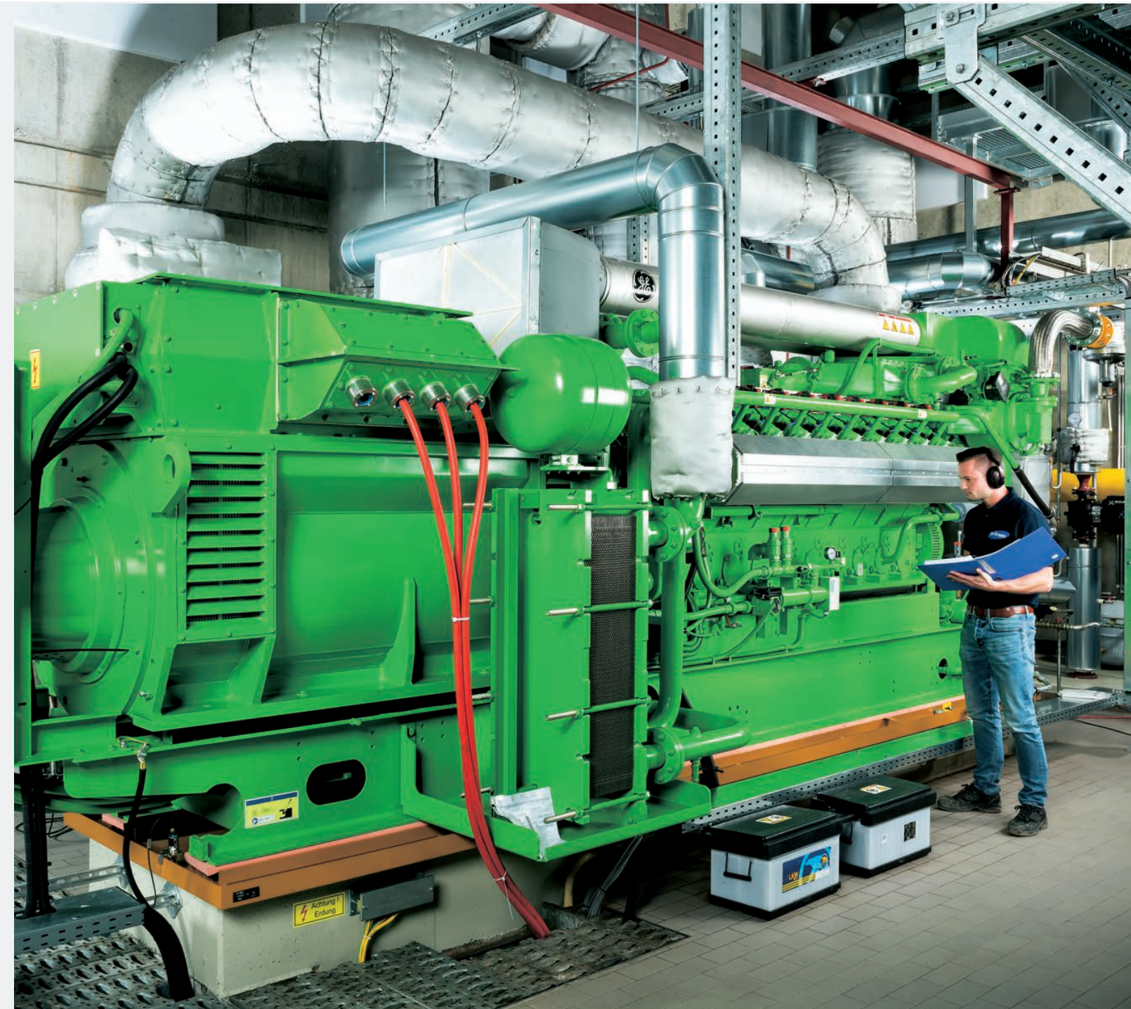
Gasmotor und Stromgenerator im Heizkraftwerk Grünäcker
