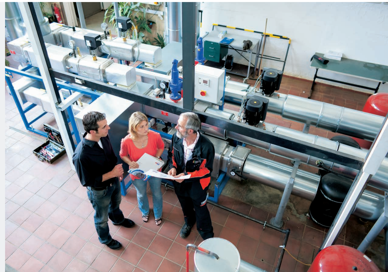
Fernwärme-Übergabestation mit 2.500 KW
