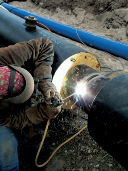
Schweißarbeiten an der Fernwärmeleitung
