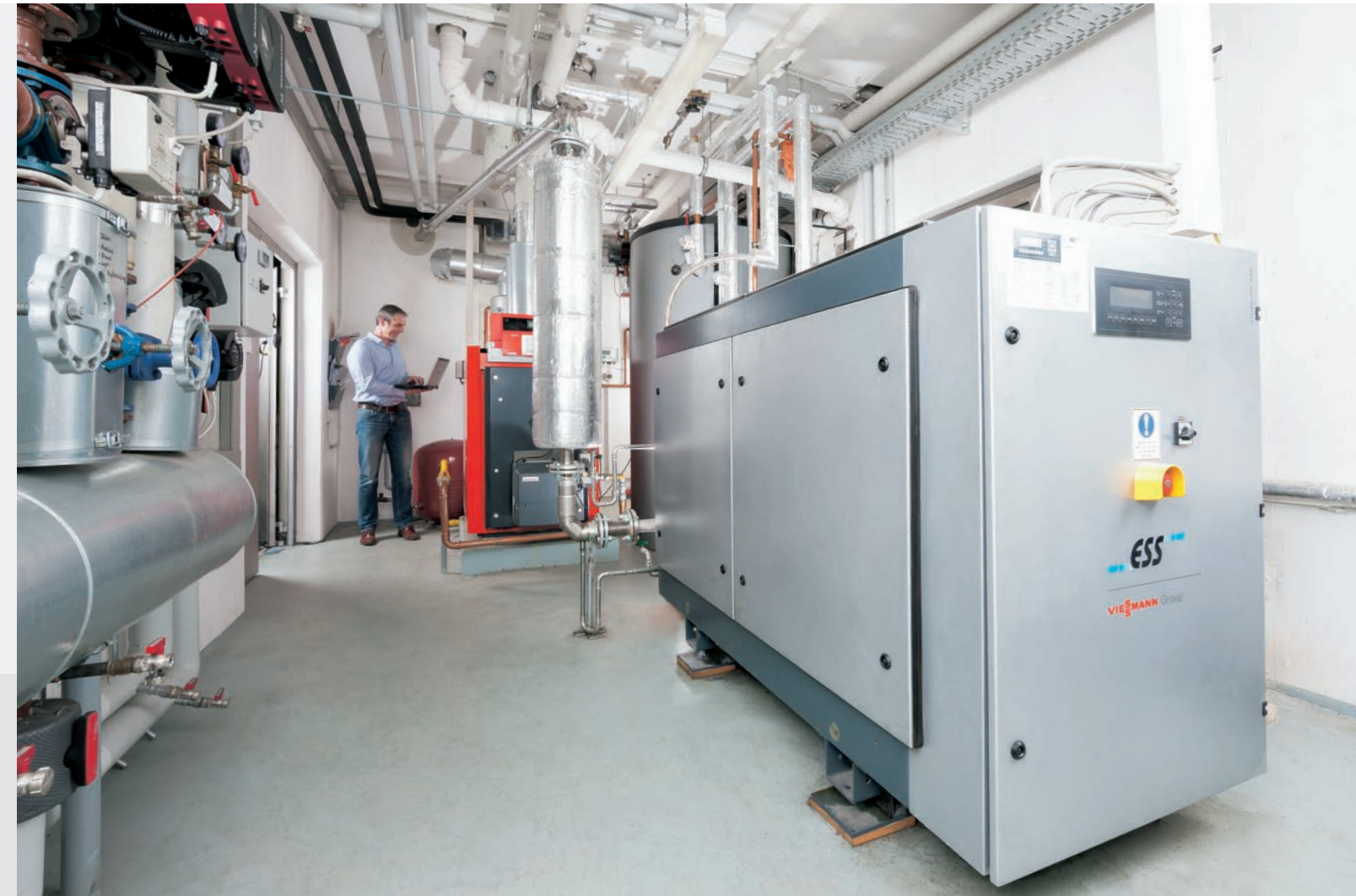
Heizzentrale in einem Contracting-Projekt mit einem BHKW Modul mit 100 kW el
