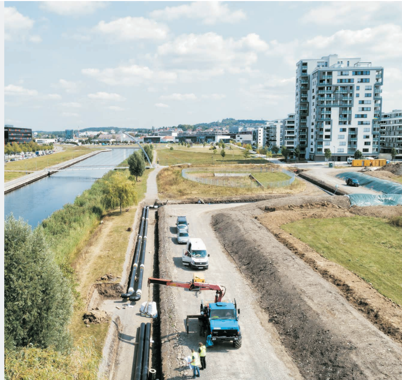
Bau der Fernwärmeleitung auf dem Flugfeld
