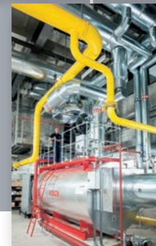
Installation eines Spitzenlastkessels mit 5.200 kW im HKW Grünäcker
