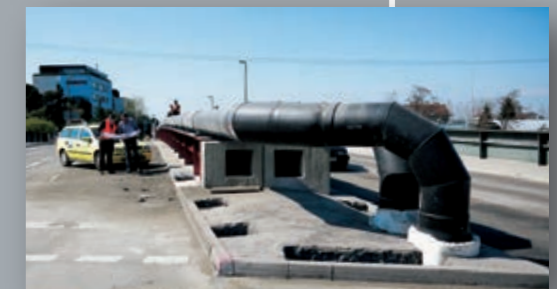
Bau der Fernwärmeleitung zwischen Sindelfingen und Böblingen
