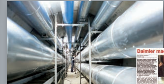
Die Wärmeauskopplung aus dem Kraftwerk der Daimler AG beginnt
