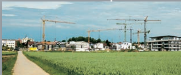
Baugebiet Allmendäcker wird erschlossen
