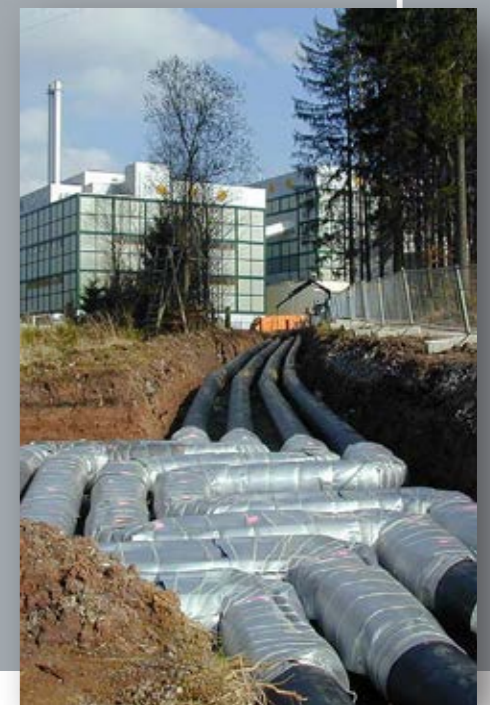
Die Fernwärmeleitung für die Abwärmenutzung aus dem Restmüll- Heizkraftwerk wird gebaut
