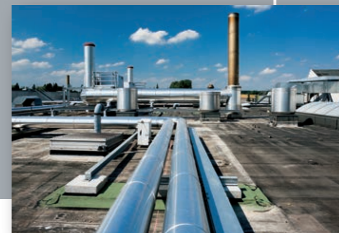
Die Abwärmennutzung aus der Druckerei Körner wird gebaut und in Betrieb genommen
