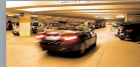
Übernahme der Parkierungseinrichtung in der Tiefgarage Marktplatz
