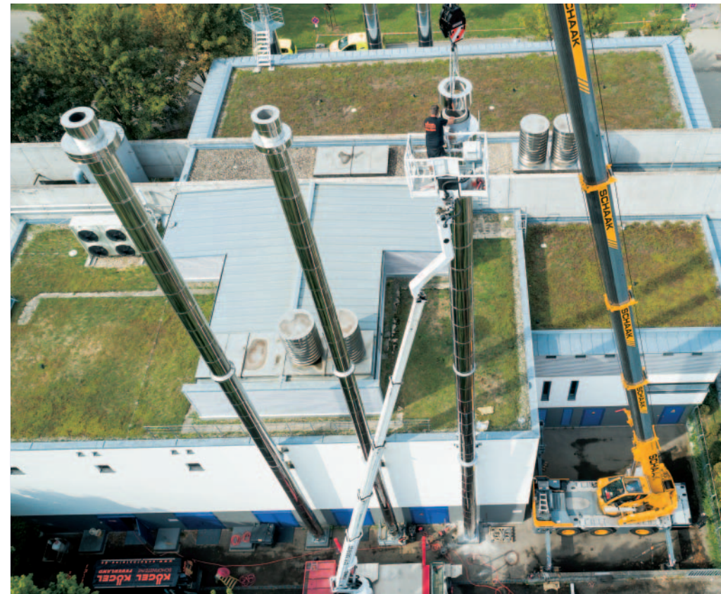
Montage der Abgasanlage des neuen Gasmotors im Kraftwerk Grünäcker
