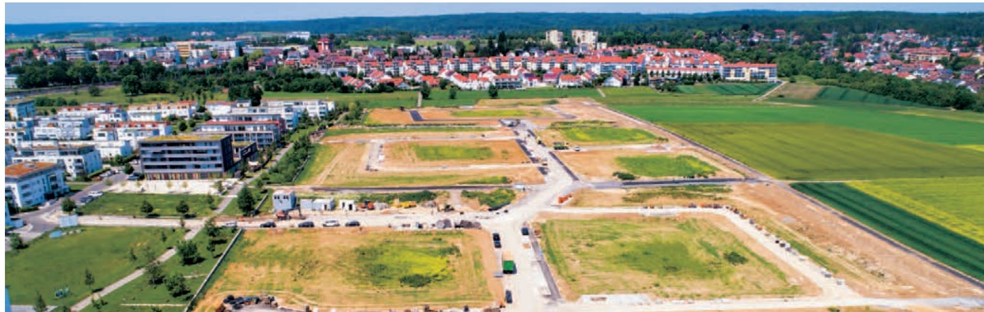
Erschließung des Baugebiets „Allmendäcker II“ in Maichingen
