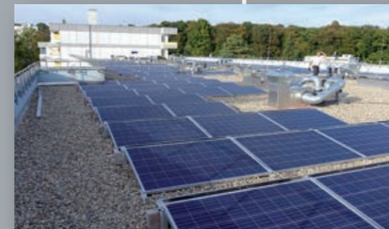
Erstes Mieterstrommodell: in einem Mehrfamilienhaus können die Bewohner den Strom vom eigenen Dach beziehen
