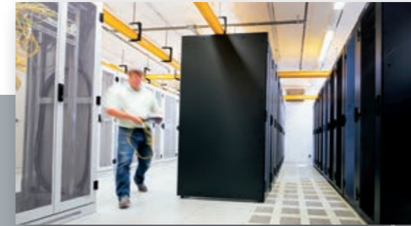
Einstieg in IT- und Kommunikationsdienstleistungen. Das Datacenter wird gebaut
