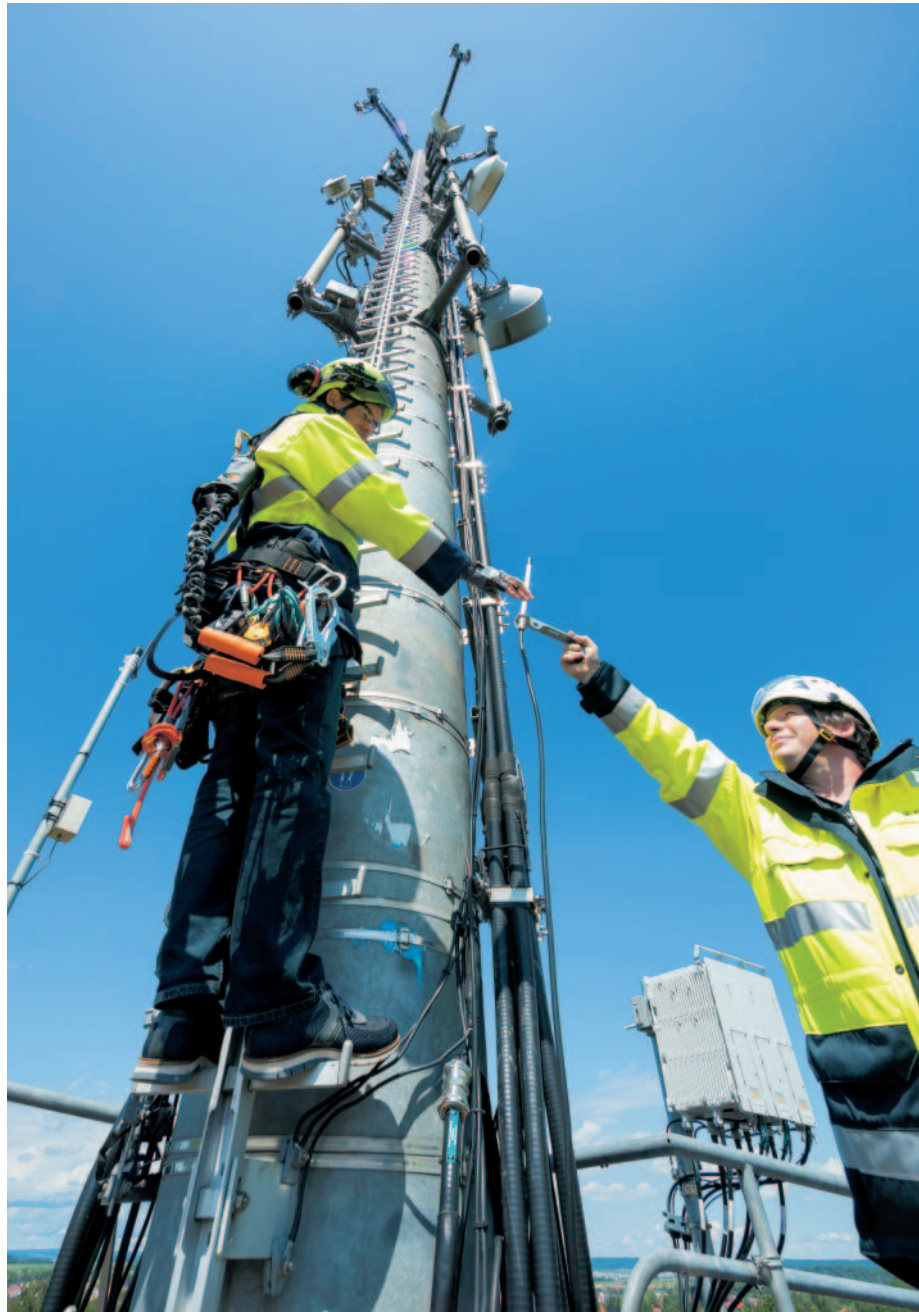
LoRa Antennenmontage auf dem Wasserturm Eichholz
