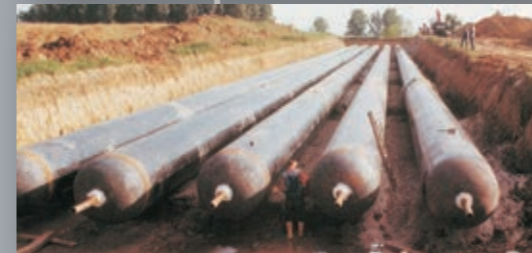
Bau des Erdgasspeichers mit 90.000 m 3 in der Rudolf-Harbig-Straße
