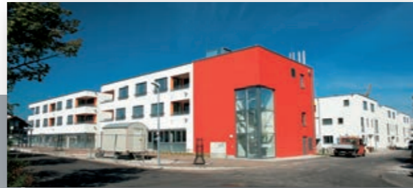
Das neue Blockheizkraftwerk „Im Hölderle“ in Darmsheim geht ans Netz
