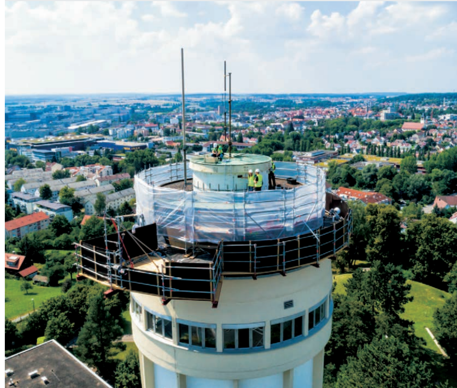
Sanierung des Wasserturms Goldberg
