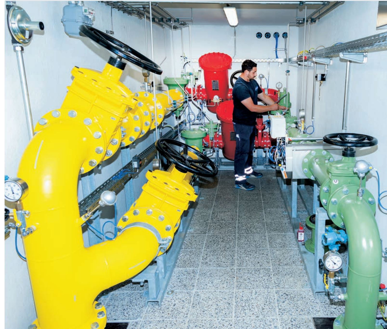
Inbetriebnahme der neuen Gasdruckregelstation Eichholz
