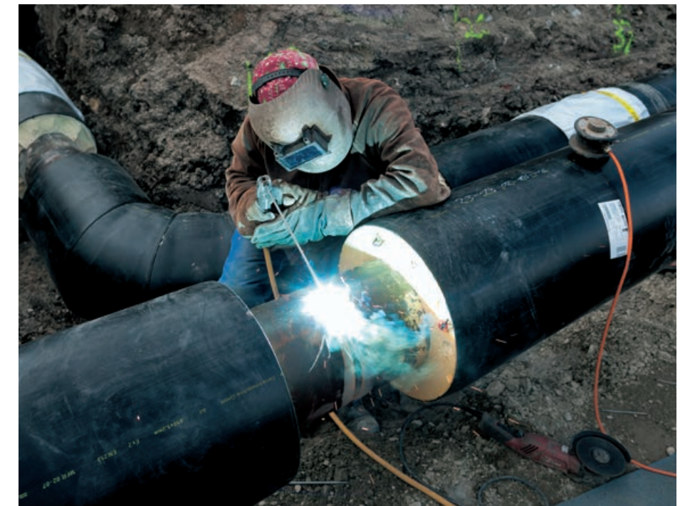
Verschweißen einer Fernwärmeleitung auf dem Flugfeld
