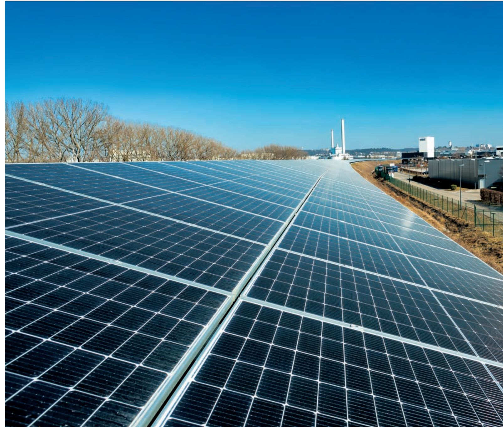
700 kW p Photovoltaikanlage mit einer Länge von 800 m auf dem Lärmschutzwall Flugfeld
