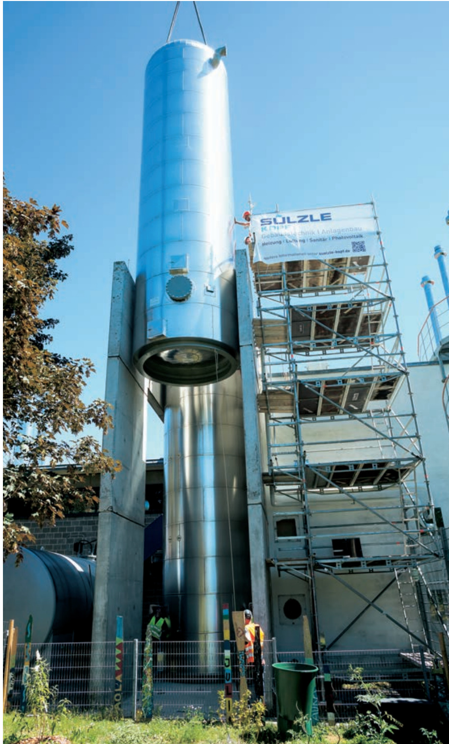
Die Pufferspeicher im Kraftwerk Grünacker tragen wesentlich zu einer effizienten Betriebsweise bei und sparen so Primärenergie ein.
