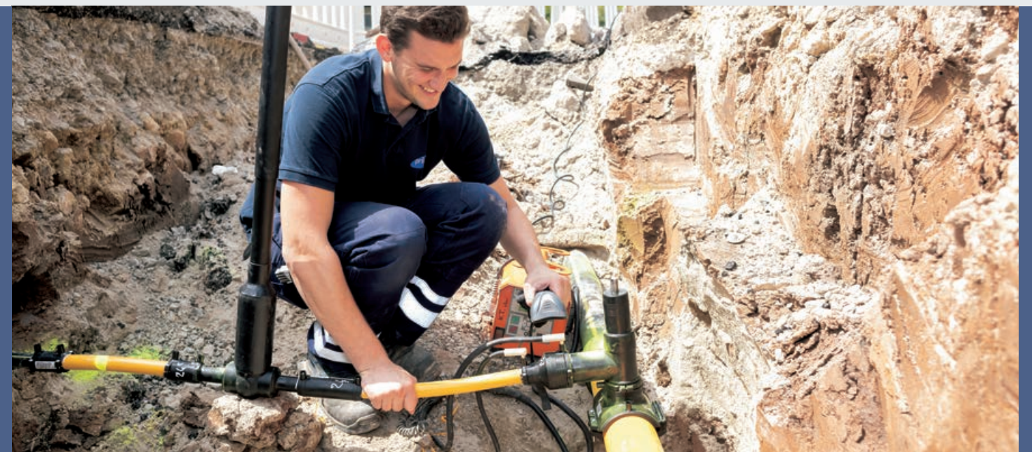
Verschweißen eines Erdgashaushaltsanschlusses
