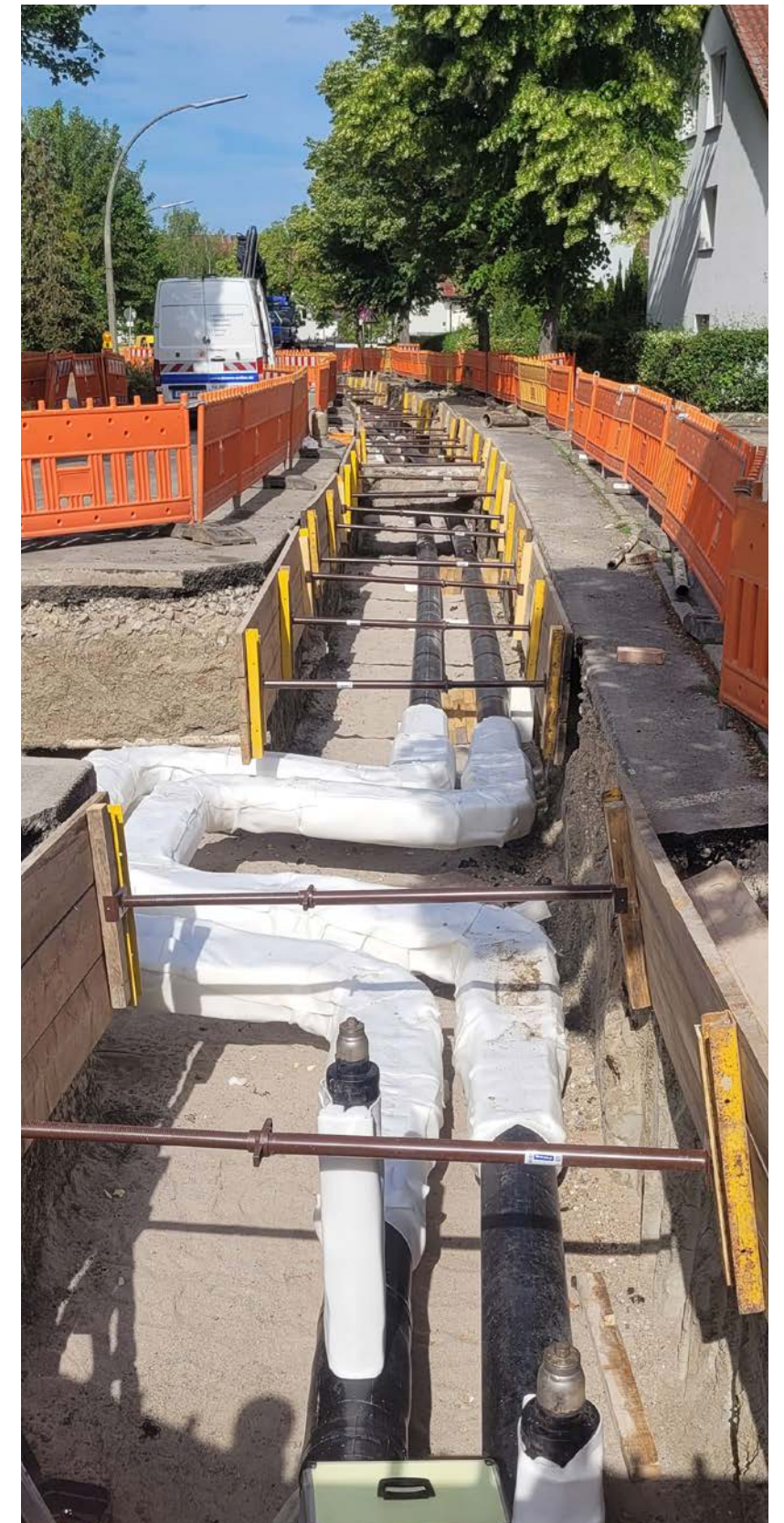
Bau einer neuen Fernwärmeleitung in der Goldmühlestraße
