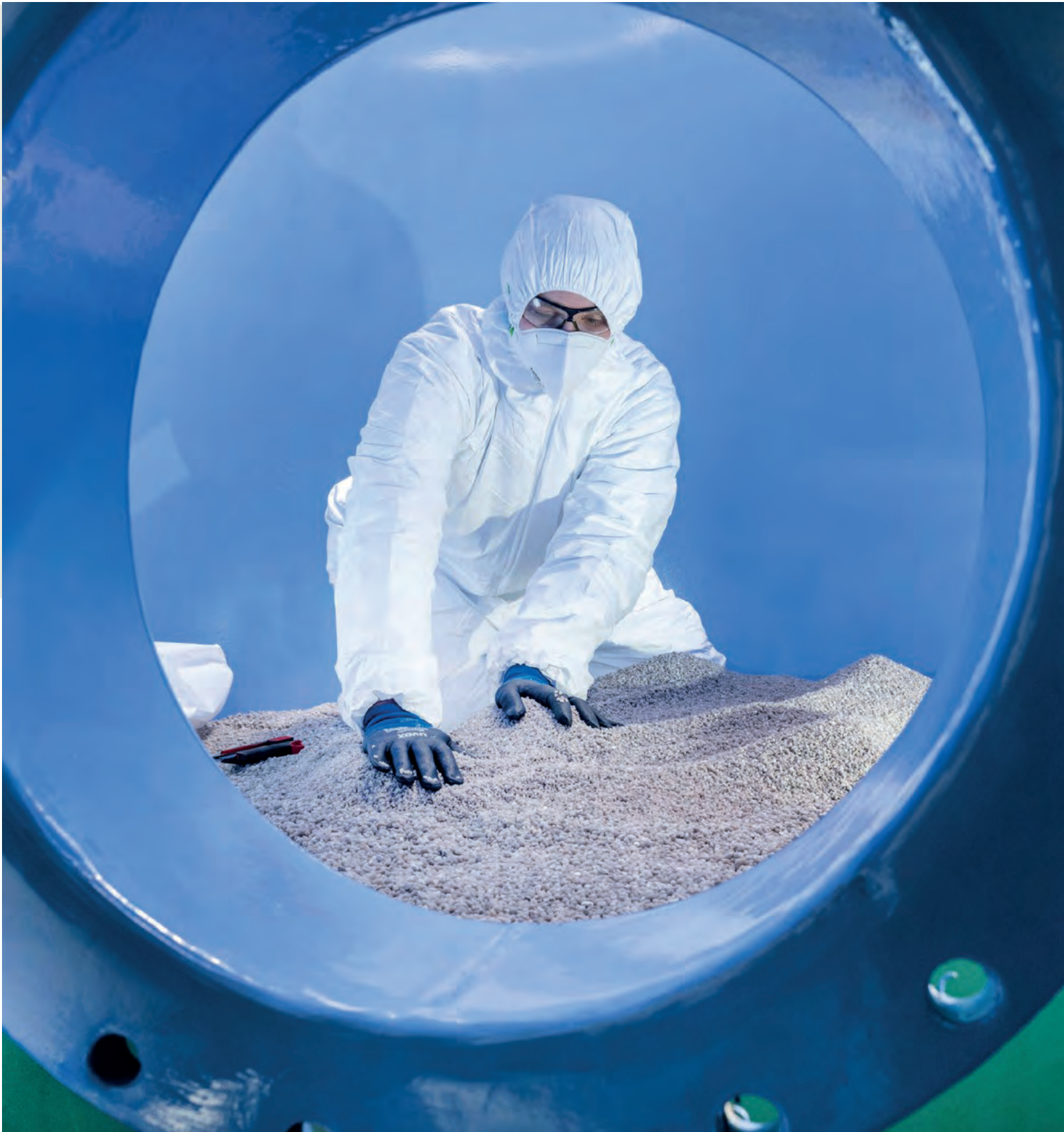
Sanierungsarbeiten im Wasserwerk See: Das Foto zeigt die Befestigung des Sandkohlefilters als Stützschrift
