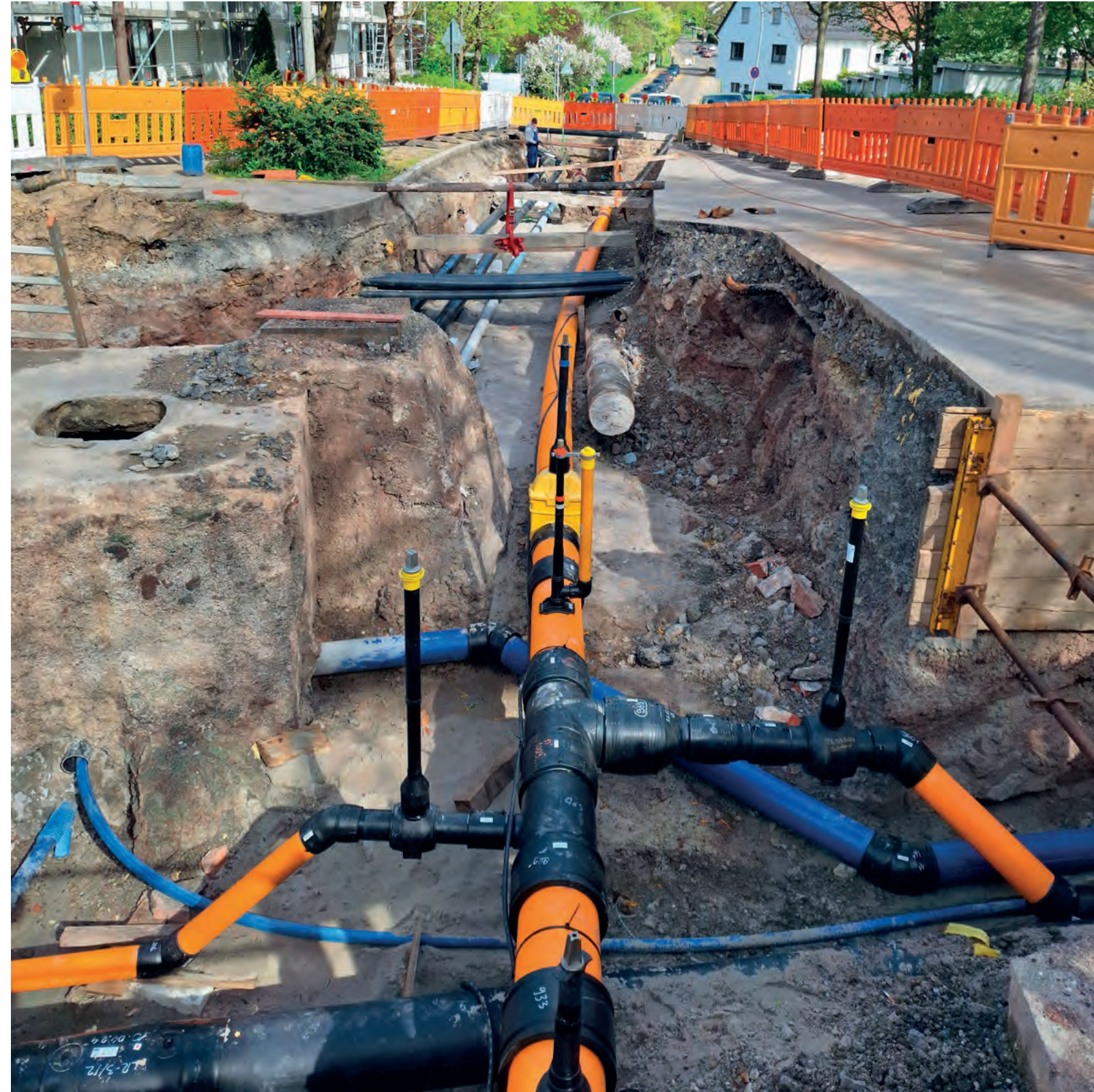
Sanierung einer Gasleitung in der Straße Lange Anwandten.
