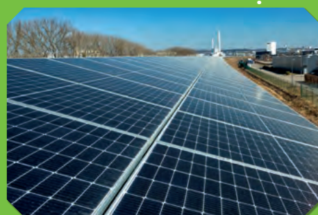
Die Fotovoltaikanlage auf dem Lärmschutzwall der A81 wird mit 700 kWp in Betrieb genommen
