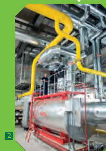
Installation eines Spitzenlastkessels mit 5.200 kW im HKW Grünäcker
