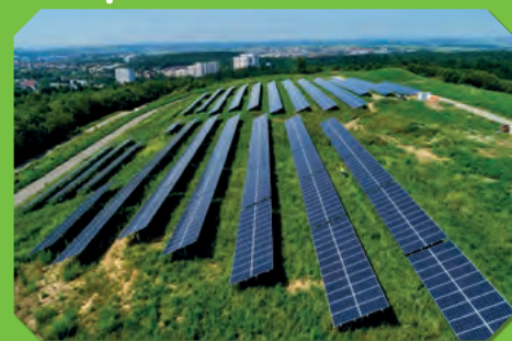
Die Fotovoltaikanlage auf der ehem. Deponie Dachsklinge mit 750 kWp nimmt den Betrieb auf
