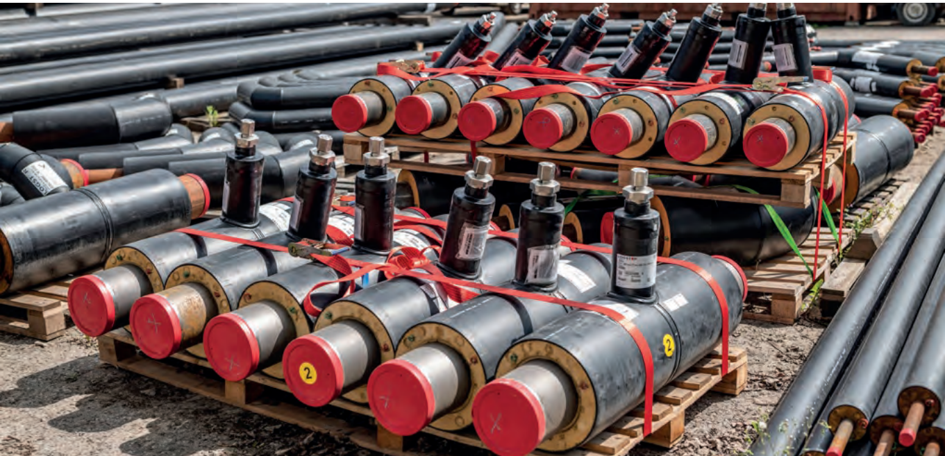
Zwischenlager für Fernwärmerohre in der Tübinger Allee
