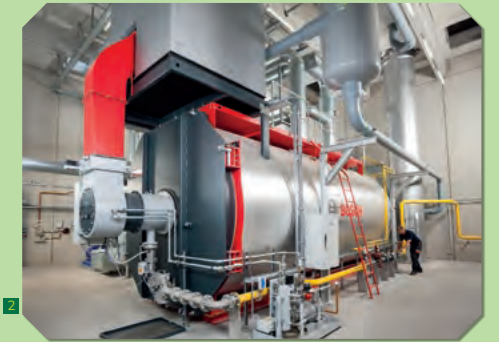
Neuer Heizkessel im Heizwerk der FTG am Restmüllheizkraftwerk Böblingen zur Erhöhung der Versorgungssicherheit
