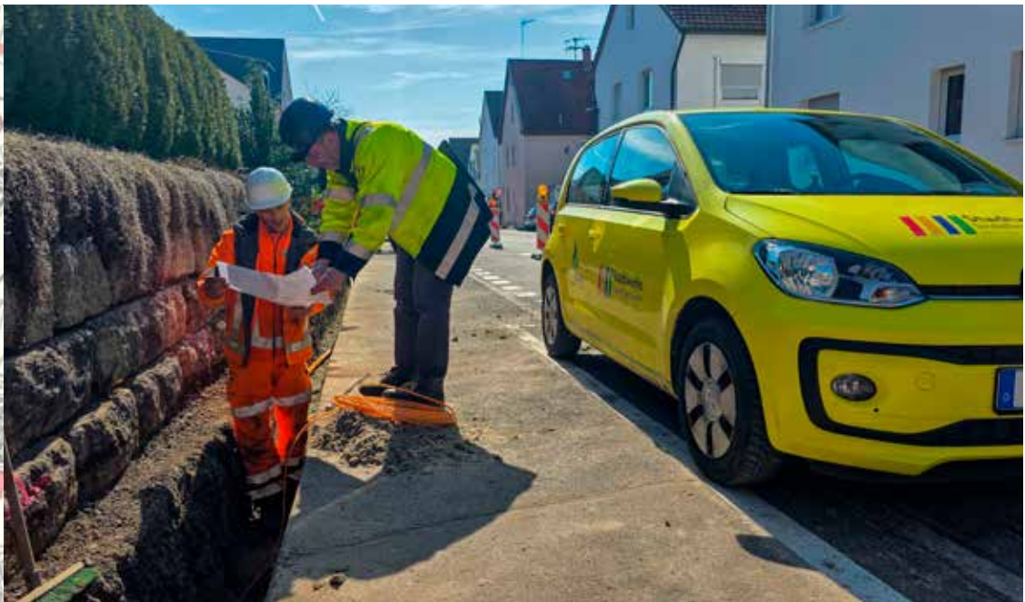
Arbeiten auf einer Baustelle zum Glasfaserausbau in Sindelfingen
