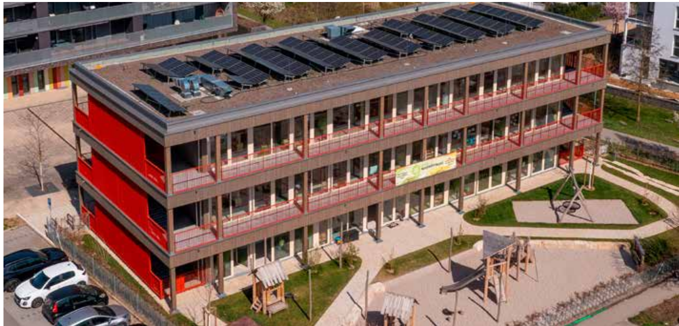
PV-Anlage auf dem Dach einer KiTa im Allmendäcker in Maichingen
