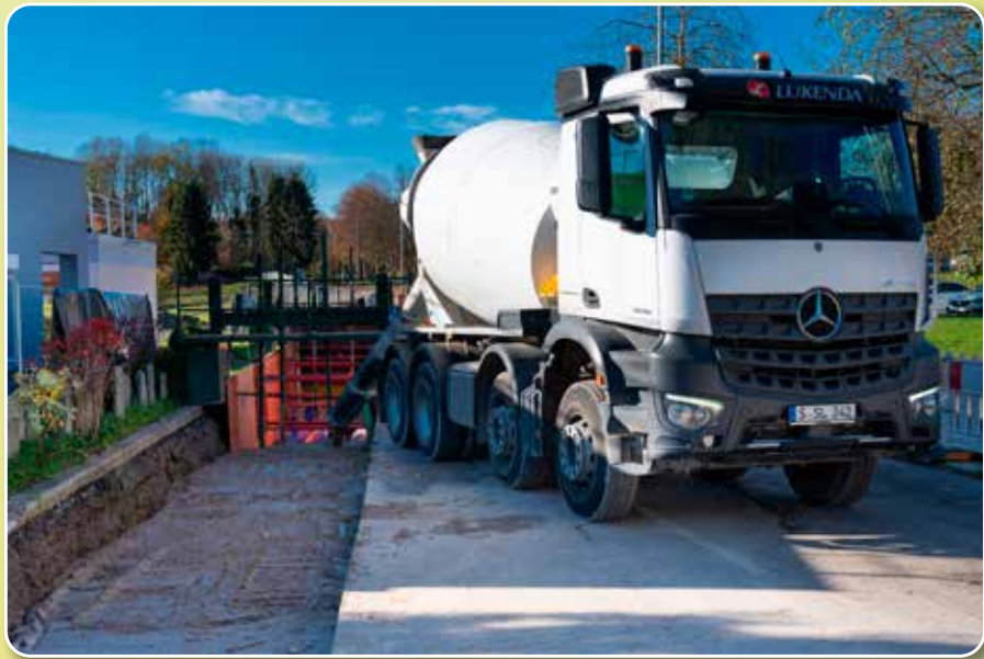
Baustelle mit Flüssigboden-Verfüllung in der Rudolf-Harbig-Straße
