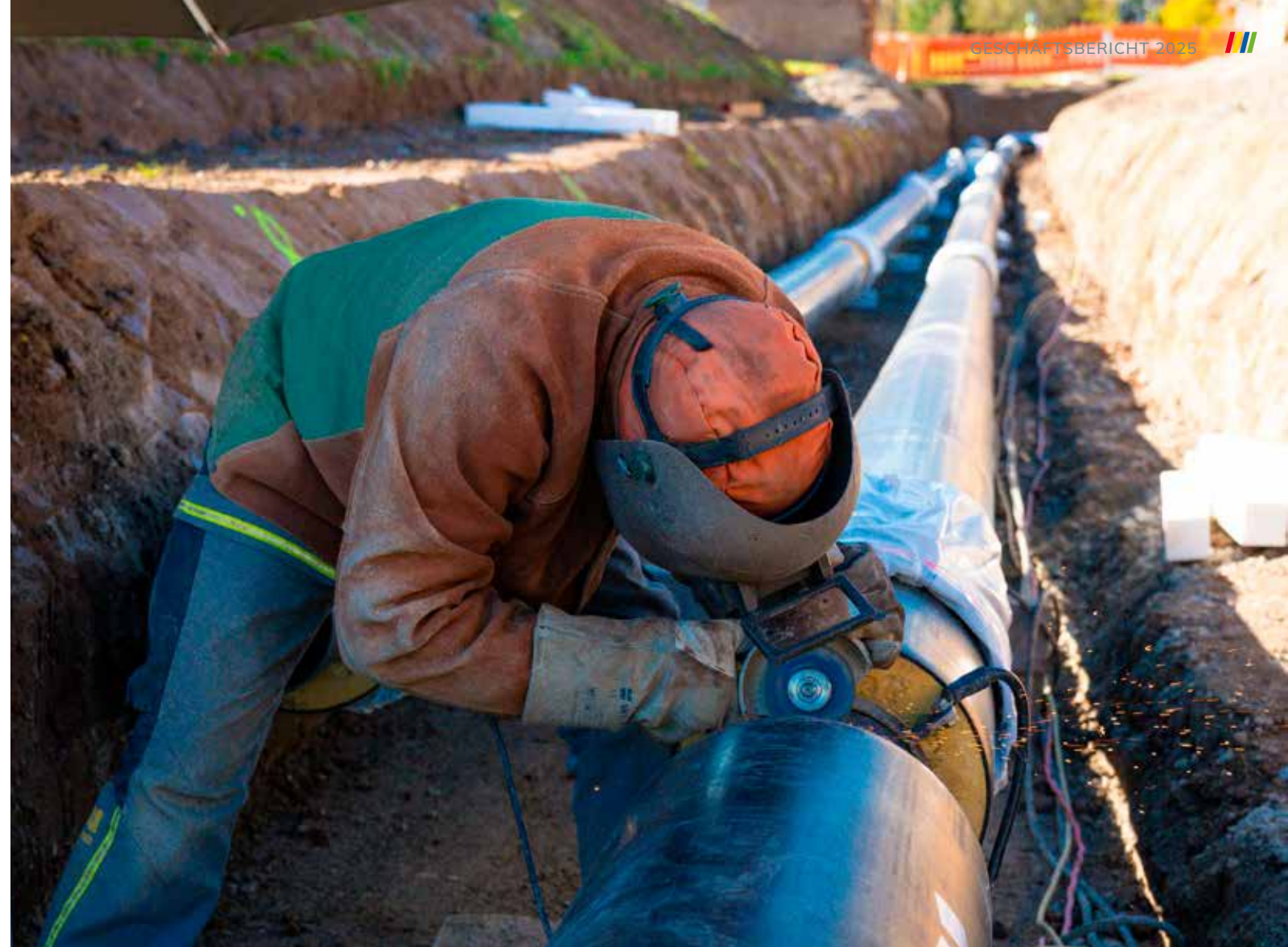
Schweißarbeiten an einer neuen Fernwärmeleitung
