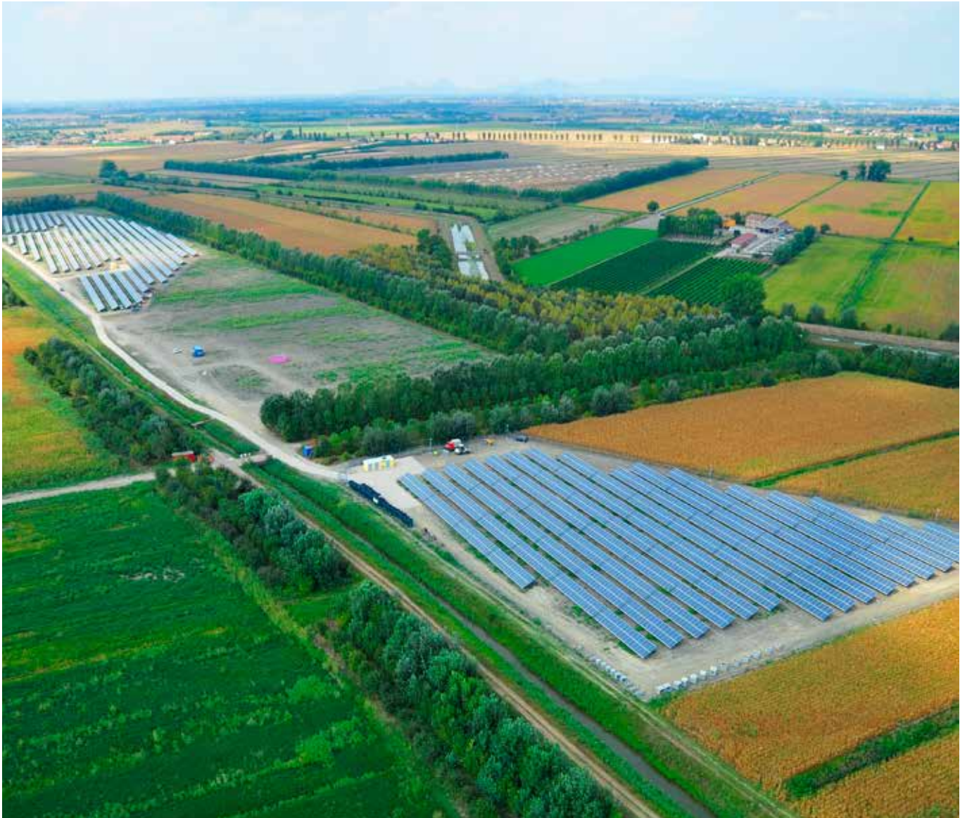
Solarpark Cavarzere, Venetien, Italien
