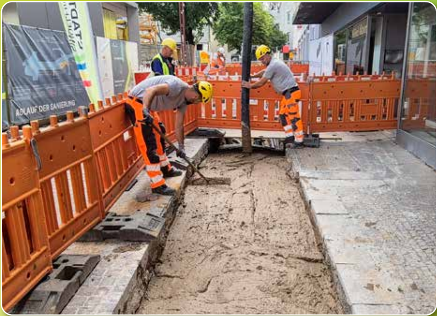
Einbringung von Flüssigboden auf dem Sindelfinger Marktplatz
