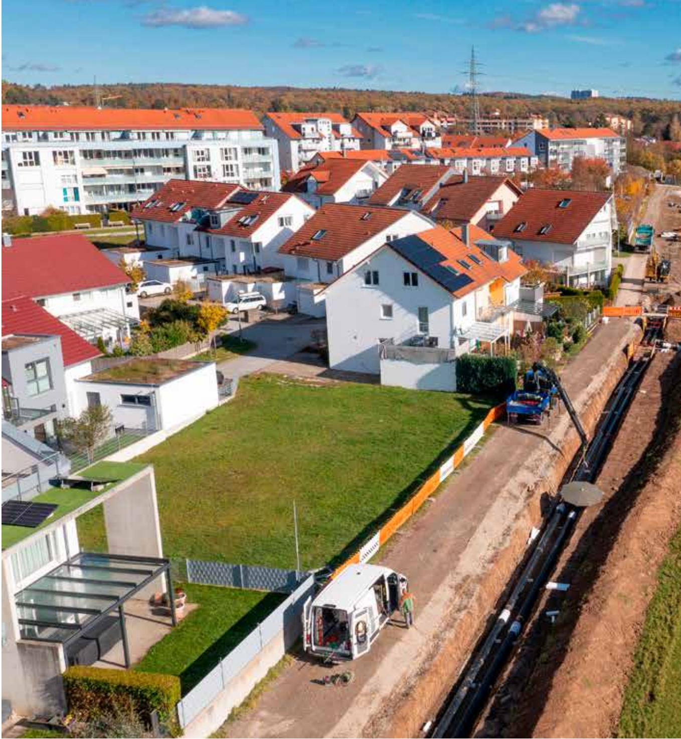
Fernwärme-Anschlussleitung für das Wohngebiet Hinterweil
